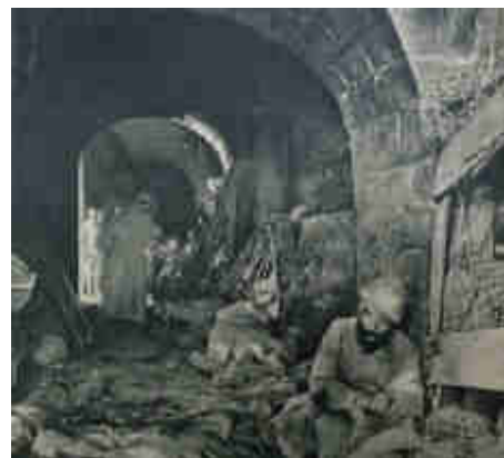
Le couloir central du Fort de Vaux (Meuse) où a été tué Ansbert Singlas le 22 avril 1916
